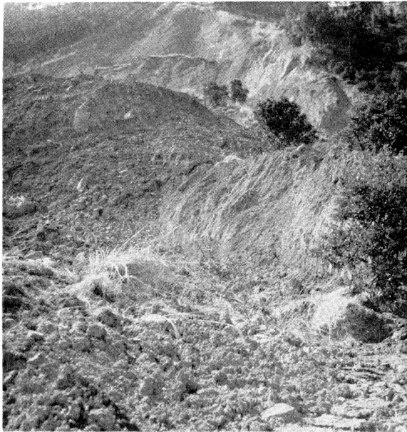
崩壊およびその堆積 頭部が大きく崩れ その土行が堆積している
