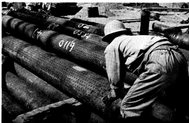
(第13図) 新掘井の孔明管
