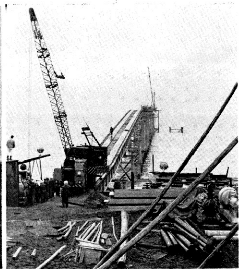
潟町海岸の人工島築造工事
