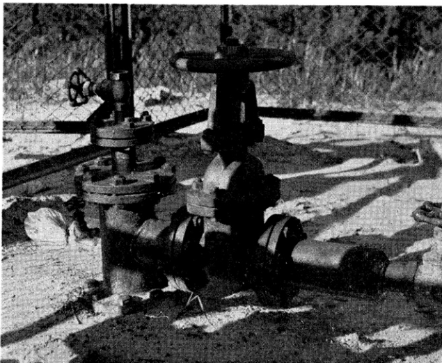
東新潟ガス田250m層の坑井 最近水がついて休止井となった(日本瓦斯化学工業KK 松浜 M1-4'井)
