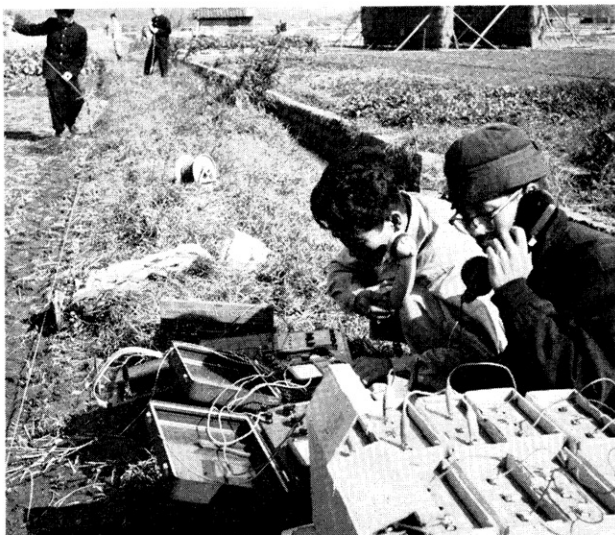
比抵抗法で垂直探査を行っているところ 電極の移動や接地状況等は連絡係と観測者との間で電話連絡をする。前方に電極係が2人見える
