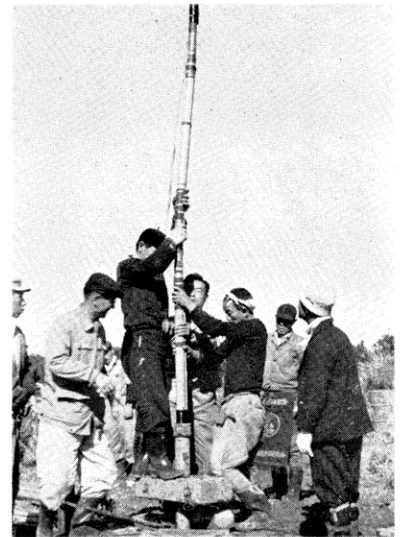
⑤ 遅延管を付けた爆薬を爆発孔に挿入する 作業
