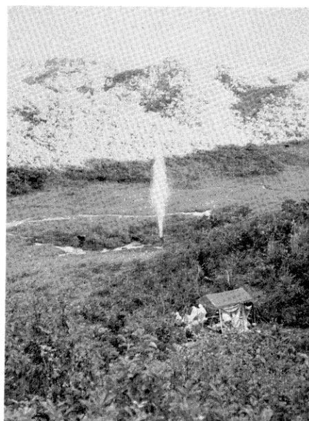
人形峠恩原地区の地震探査 ワラン河流域恩原の爆破 手前テントが観測本 部 測線は約2.9kmで左から右へ通っている
