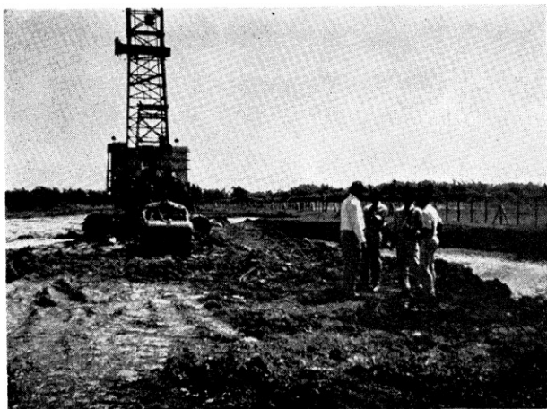
グレシックのセメント工場の粘土採掘場(スラバヤ近郊)
