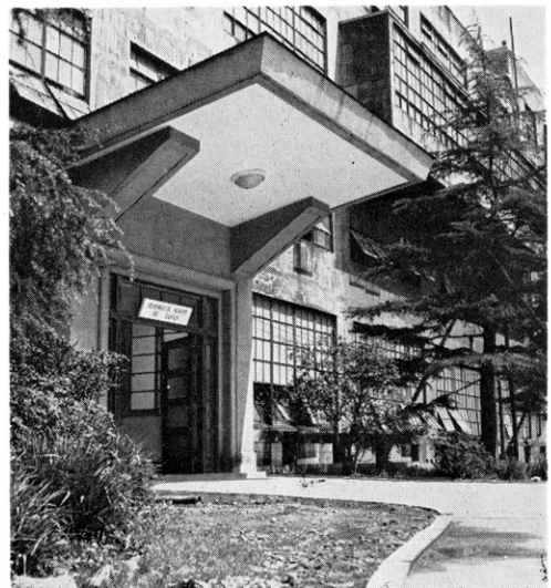
溝ノ口本所正面玄関
