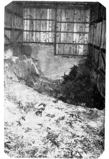
第三地点の現在の断層露頭 (網野町役場提供)
