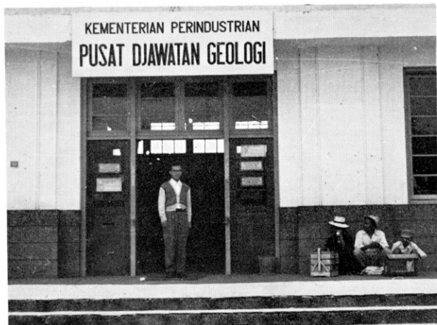
インドネシア地質調査所正面玄関
