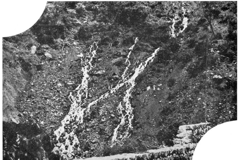
著しく破碎された岩石中に発生した崩壊 滲透水がしみ出しているのがくせものである 写真中央や左方に判然としないが水抜き坑が見られる この現場はみかぶ破碎帯の1部分である
