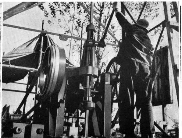
R-500型ハンドフィード式試錐機(国産)を使用した静岡市内の工業用水調査 動力10~20HP掘進能力500m 本体の重量1,100kg 回転数80~120 r.p.m.
