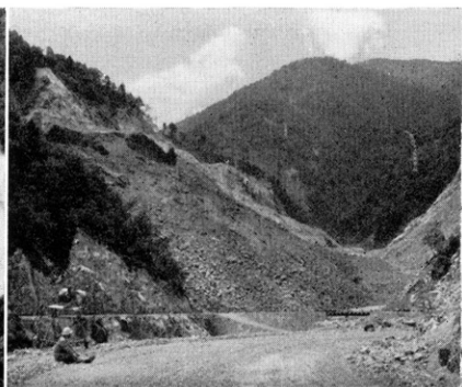
爆破後の全景
