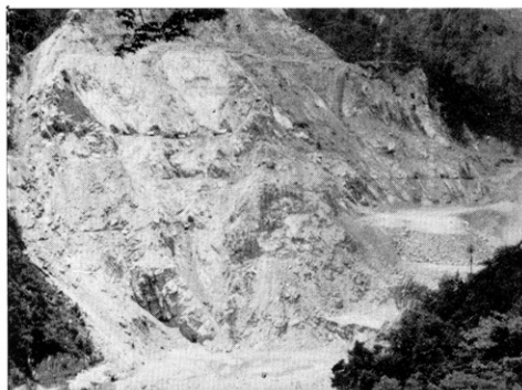
爆発寸前 ここに22の坑道が掘られ 155.8トンの火薬が装填された
