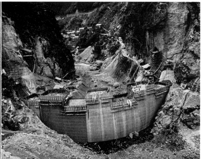
完成した殿山ダム(アーチ式) 堤高: 62 m 最大出力: 15,000 kw 総貯水量: 30,643,000 m^3 地質は時代未詳中生層中の礫岩 所在: 和歌山県西牟婁郡大塔村〔日置川水系〕 工事中の殿山ダム (関西電力K.K.提供)
