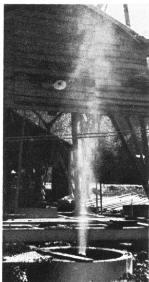
試錐孔からの炭鉱ガス噴出状況 (常磐炭鉱提供)
