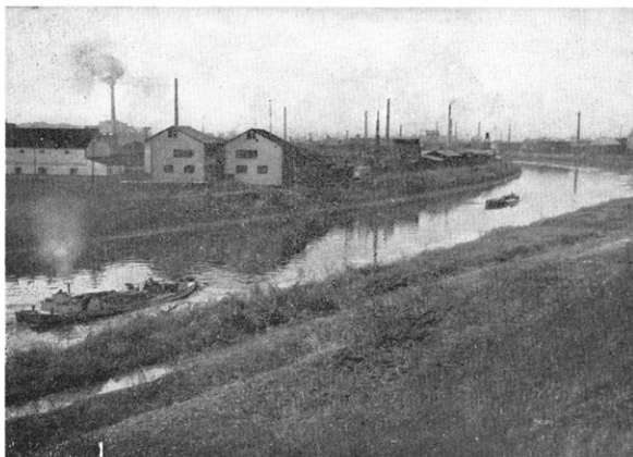
新河岸川沿いの都北工業地区
