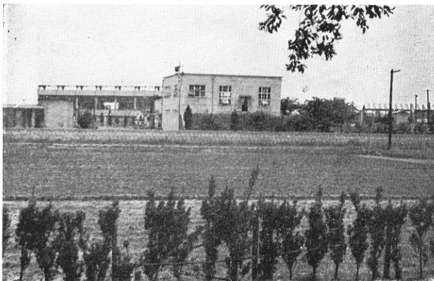
上水道や簡易水道も深井戸を水源としてあちこちででき上がっている(6本の深井戸の水を集める川口市浄水場)
