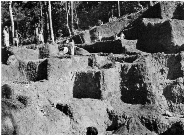
ルールケラ地区のマンガン採掘場 (鉄鉱層準の上位にある珪板岩中には鉄鋳同様重要な鋳物資源である良質のマンガン鋳(二酸化)が露天掘で採掘されている)
