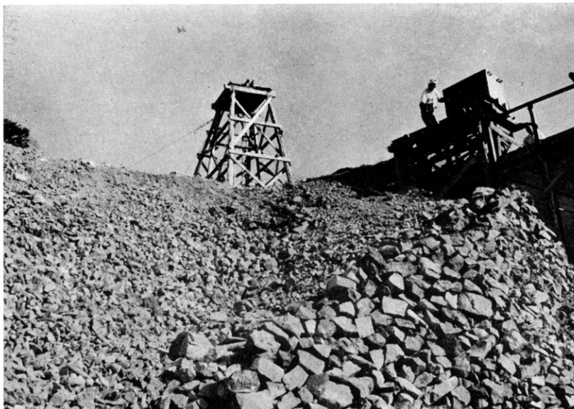
松岩鉍山前田堅坑とボタ場 この堅坑で45m降りたところに下一番坑 さらに30mすなわち75mに下二番坑がある 1957年8月この下一番坑で新しく閃ウラン鉍を発見した
