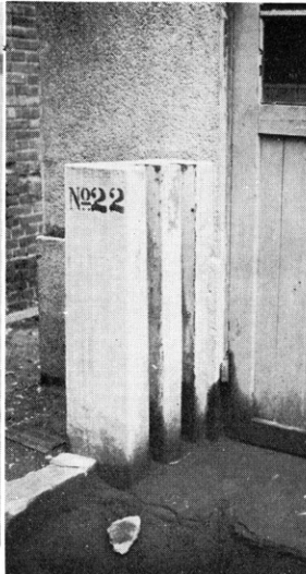
浸水を防ぐための 遮水扉の差入口
