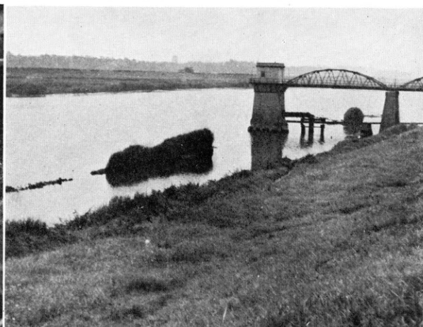
関東平野の中央から最大 4,500m 3 秒の水を流して行く江戸川 ここにもまだ利用できる水量が予想される(江戸川に取水する東京都上水道金町浄水場の取水塔)
