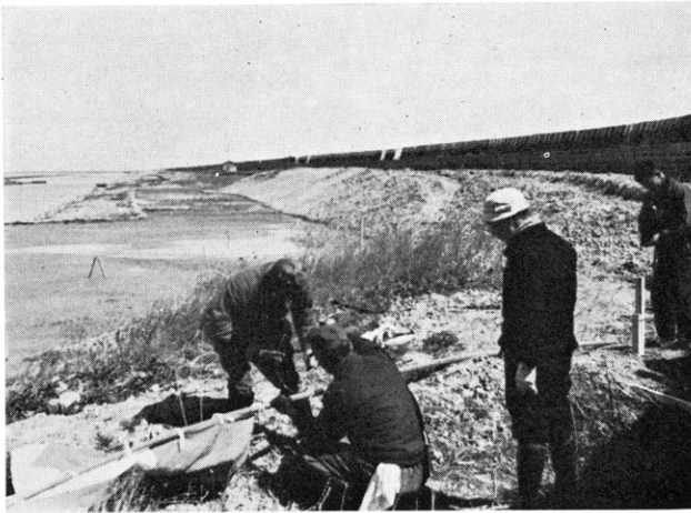
測量基準点の標識をつくる
