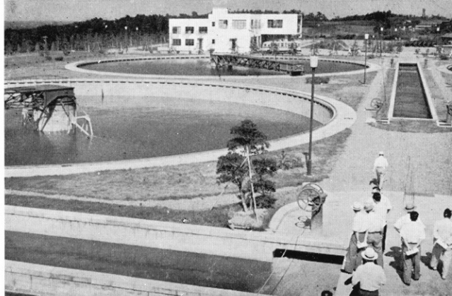
川崎市長沢浄水場。相模湖の水を取り入れて上水道源水とともに工業用水道源水の浄化を行っている
