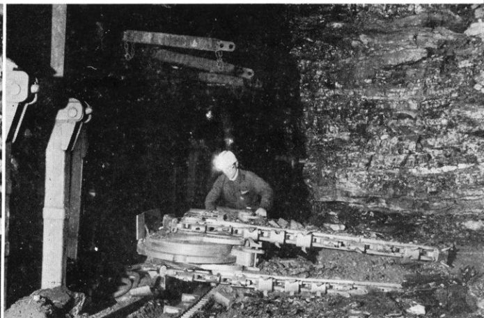
三池炭田のダブルシブ コールカッターによる採炭（三井鉱山k.k.提供）
