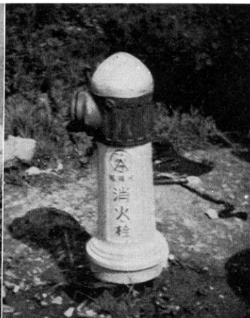
自噴性掘抜がそのまま消火栓に利用されている(大垣の例)
