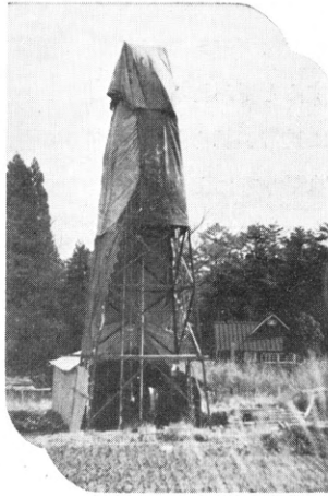
鹿兒島県始良郡霧島村 湯之野 試錐現場
