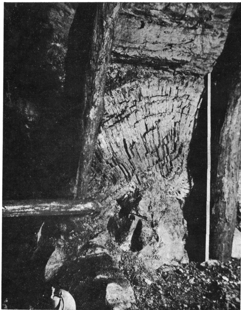
天草大岳炭鉱本卸、左大切2尺層の“カワラケ炭”柱状節理
