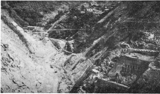
宮崎縣上椎壱工事現場
