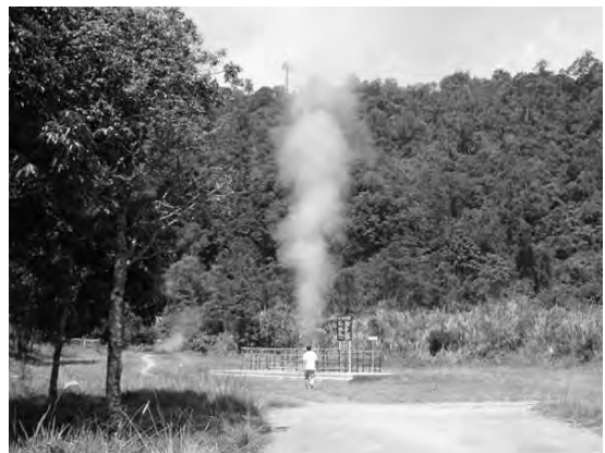
写真1 カモジャン地熱地帯(インドネシア)で1928年に掘削された調査井からの蒸気噴出. オランダ統治時代に掘削されたが, 今日まで暴噴が続いている(西日本技術開発(株)殿より借用).
