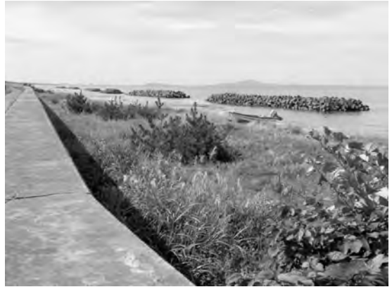
写真7 八森小学校脇の海岸. 離岸堤が見渡す限りどこまでも続いていました.
