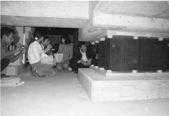
写真7 東大地震研究所の新研究棟の基礎は免震構造でした。
