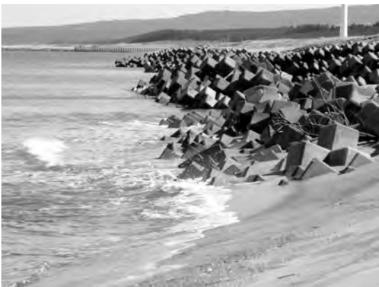
写真9 酒田北港の浜辺。砂浜は狭まり、侵食防止のテトラポッドが並んでいます。
