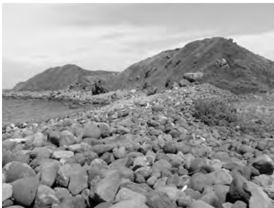
写真26 飛の波除石垣。丘と丘の間の低地(田畑)を守るように造られています。
