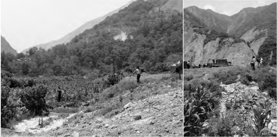
写真10-11 黒木耳養殖場のある河川階状地に現れている断崖。河川側(NW)が持ち上がりながら右横ずれし、一続きに平らだった畑が食い違って2mの垂直変位を示している。右の写真の手前中央に見える道が地震前は真っ直ぐであったが、現在は約3mの右横ずれ変位を示している(写真右側の人物が道に立っている)。
