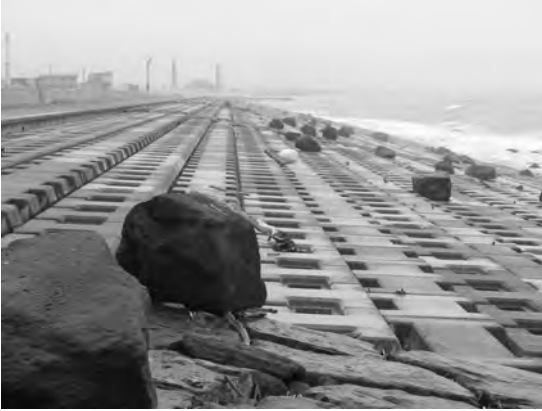
写真31 錦岡の緩傾斜護岸。基礎に使用した大きな火山岩塊があちらこちらに打ち上げられている。
