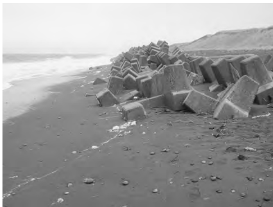
写真1 更岸海岸、草原下の浜辺に並べられたテトラポッドの列。
