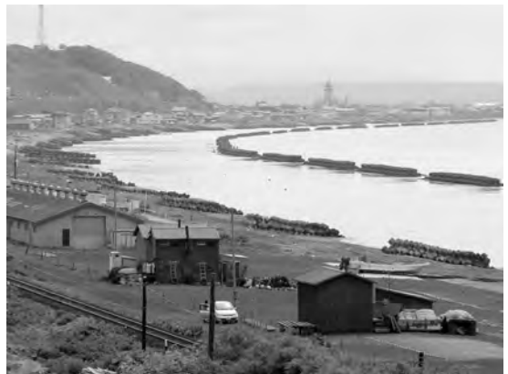
写真11 厚岸海岸遠望。たくさんの離岸堤が見渡す限り並べられている。
