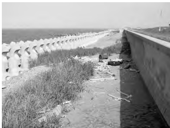
写真33 野付海岸。浸食にさらされる砂嘴外側の浜は護岸堤とテトラポッドで固められている。
