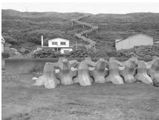
写真22 浜松海岸。テトラポッドと防潮堤で守られる、つづら折りの道は広い道路へ出る階段。
