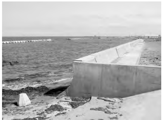
写真28 本別海の浜. 漁港と護岸堤・離岸堤が整備された海岸が続いていた.
