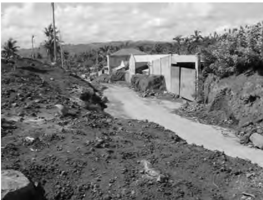
写真13 マヨン火山南西麓 Masarawag Channel。ラハールで埋まった道路を掘り起こして利用している。
