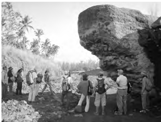
写真10 ラハールで削割された砂防ダム、ダムにトラップされた堆積物と共に4m程度の深さで浸食された。
