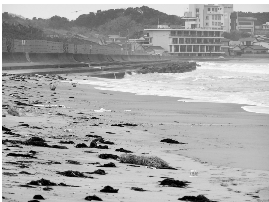
写真21 神奏海水浴場。集落近くの護岸の下で浜はなくなっている。
