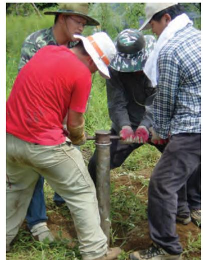
口絵4：鉛直磁場センサーの設置する穴を鉄パイプを打ち込んで掘っている。溶岩が多く、大変な労力を要する。
