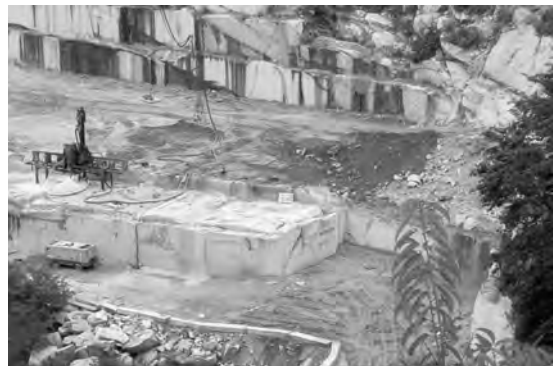
写真2 採石場での(採石)「発破」の様子。
