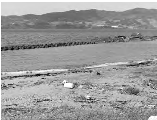
写真23 笹瀬崎。幾重にもテトラポッドが並べられ、浜や道路を冬季の高波から守っている。
