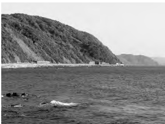
写真34 延々と続く岩石海岸。岩石は中生代の砂岩・頁岩。旧豊浦町・津波敷温泉付近。
