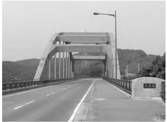
写真3 オレンジ色に塗色された万関橋。
