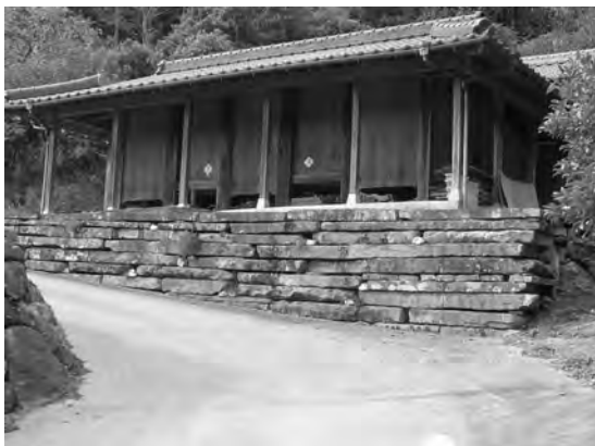
写真11 板状の砂岩を積み上げてつくられた石垣。建物は石葺きから瓦屋根に葺き替えられている。
