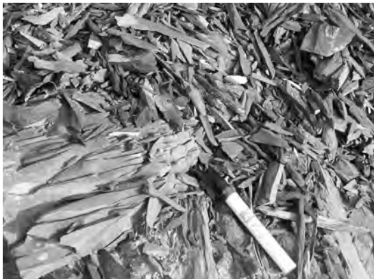
写真25 泥岩が細い棒状に崩壊して行く。画面中のマーカー白色部の長さが10cm.
