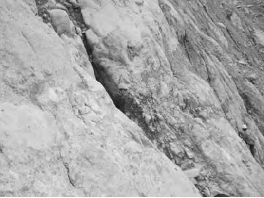
写真5 崩壊斜面の巨大亀裂。人間が楽に入れるほど大きい。岩盤は熱変質等の影響が見られずフレッシュであった。第1図のB点にて撮影。
