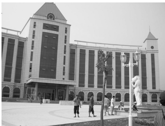
写真3 現在(2006年7月撮影)の山東省地熱基地のメインビルディング。手前に坑井がある。
