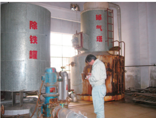
写真3 寧夏回族自治区銀川市旧市街の寧夏水利水電観測設計院の地熱井（深度3,100m）からの熱水（65℃）の採取。
