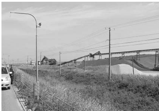
写真1 道路脇の砂プラント。プラントから手前にベルトコンベアが伸び、数種の製品が見られる。
