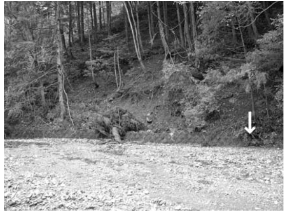
写真9 砂礫で埋められたコンクリート製の側壁(白矢印)。位置は第2図に示されています。
