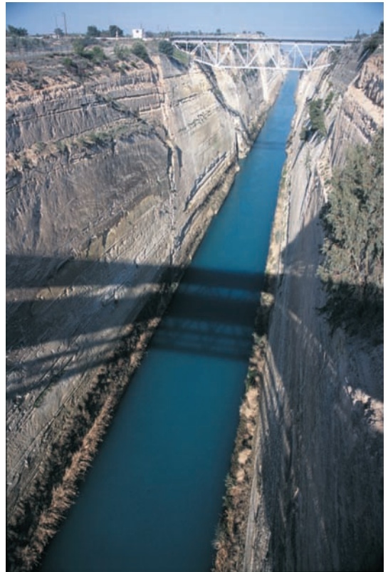
8. コリントス運河(本文写真9). ところどころに正断層が見られる。全長6,343メー トル、内壁の最高点は79.5メートルに達する。
