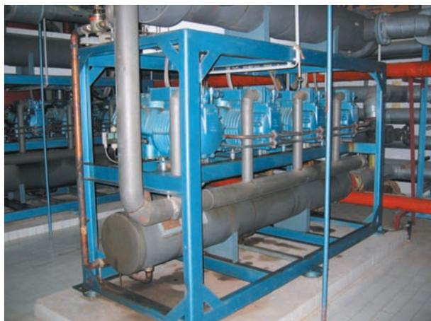
写真9 ヴェルナのホテルでの水-水ヒートポンプを使った間接地熱供給システム。
