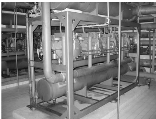
写真31 ヴェルナのホテルの間接地熱供給システム。
