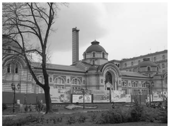
写真10 改修中のトルコ式公衆浴場.
