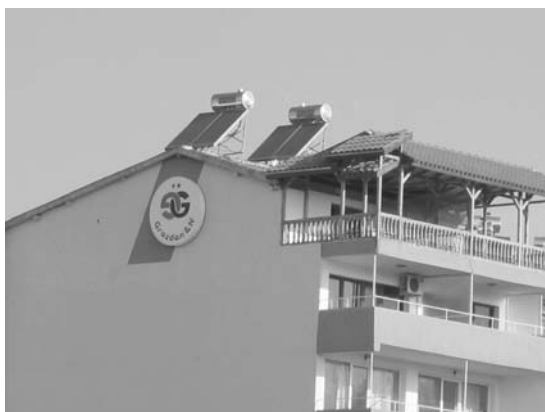
写真27 サンダンスキーの太陽熱を利用した温水器。
