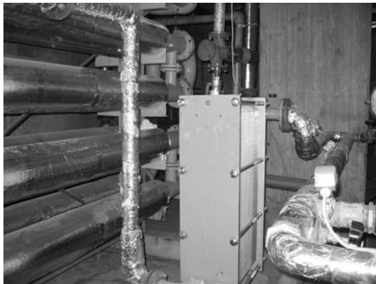
写真26 サンダンスキーの高級ホテルの間接地熱供給システム。
