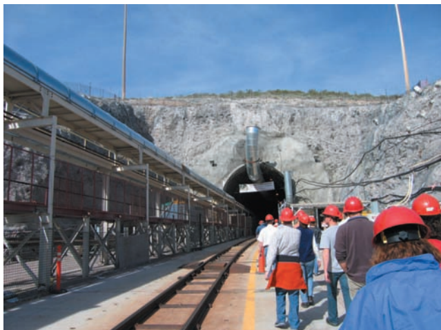
11. ESF北斜坑入口, 坑道の全長は7.65km.
