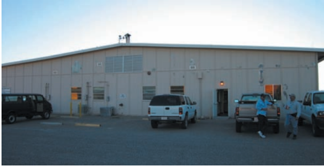
16. SMFの処理棟. ネバダテストサイト内のJackass Flatsの一面に設置されている。
