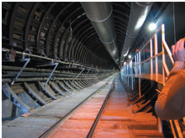
12. ESF北斜坑内部.
