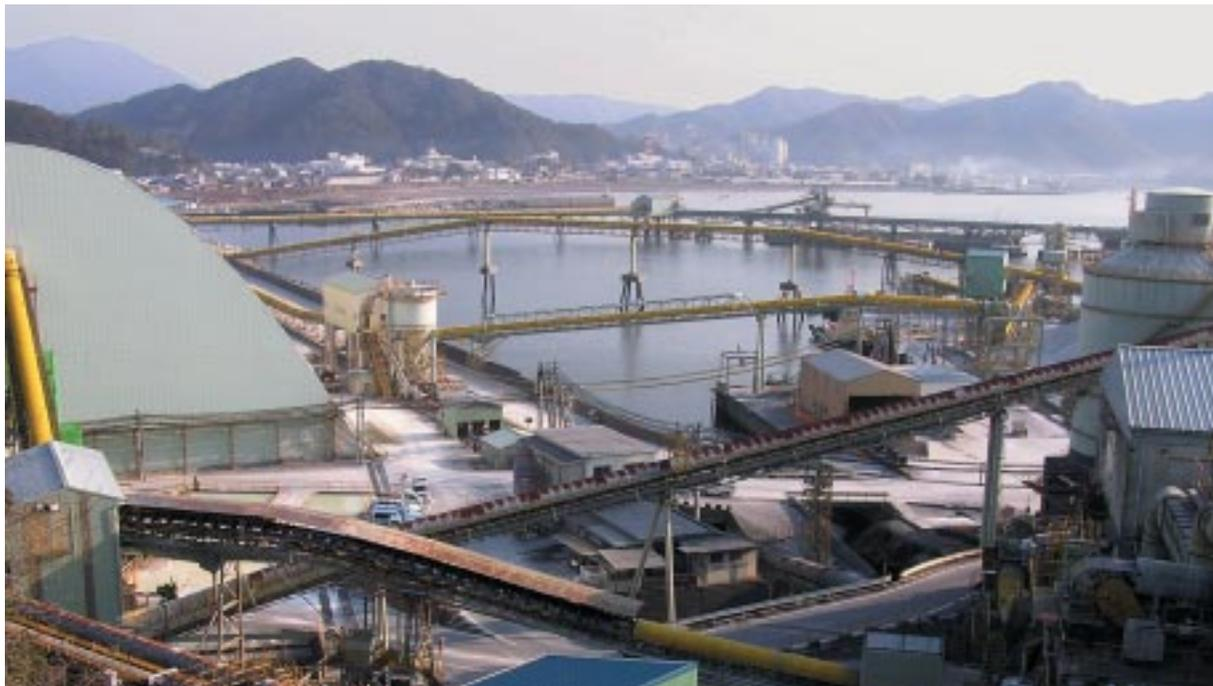
8. 須崎事業所の積出し設備。張りめぐらされたベルトコンベアの向こうに、須崎市の中心部、セメント工場が遠望される。左側の半円状屋根は鉄鋼用石灰石の貯鉱場、右側の円筒は砕砂の貯蔵庫。
