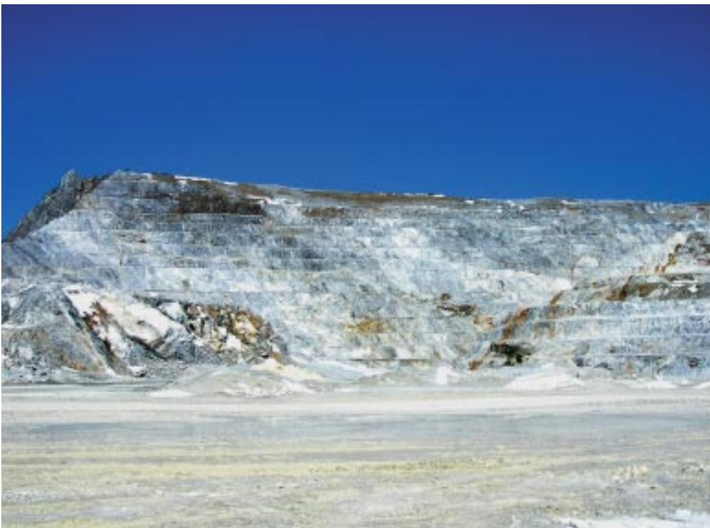
2. 採掘場中央部から見た北側残壁。石灰岩の下盤となる粘板岩が露出している。画面左側奥に、現在の山頂(標高1,346.5m)がある。真青な空を切り裂いて東へ飛ぶジェット旅客機の姿がよく見られる。
