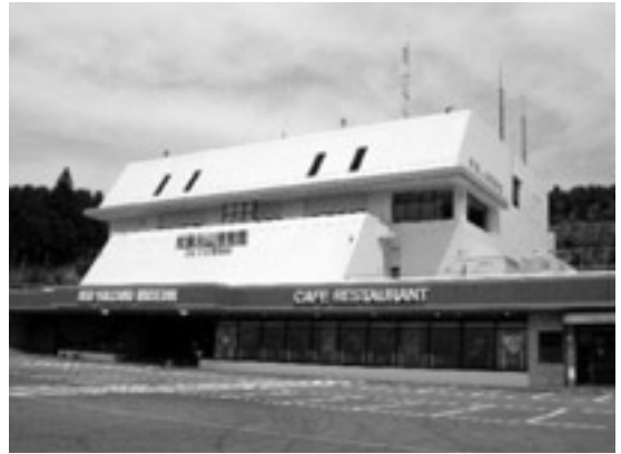
写真16 新たに塗装しなおした博物館外観。
