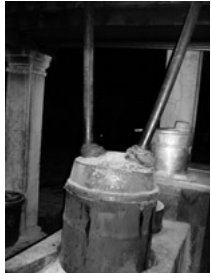
写真27 サウナの釜。釜の中で暖められた蒸気が、筒を伝わって2階のサウナ室へ上がります。
